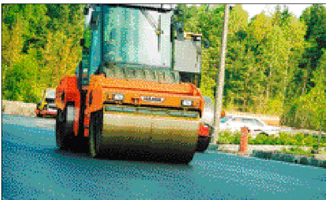
Тандемный виброкаток HD 75 фирмы Hammm для уплотнения слоев 4–6 см.
