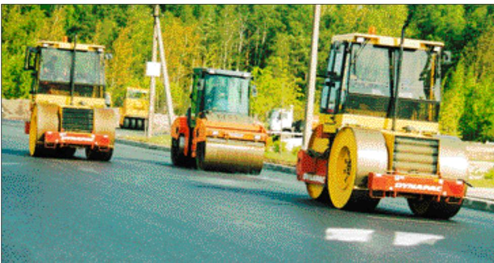
Катки вибрационные HD 75 и статические CS 141/142 уплотняют асфальтобетон по новой технологии ЗАО «ВАД».
